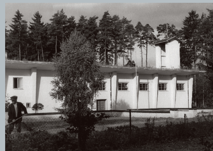
Die »Bunkerkirche« in Aschau. Werk wurde ab 1953 im ehemaligen Bunker Nr. 262 eingerichtet. Am 18. September 1953 wurde sie von Weihbischof Dr. Johannes Neuhäusler dem Hl. Josef geweiht.
